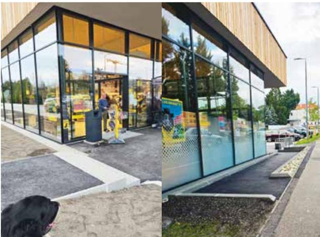
Der Zugang vom Gehsteig zum Eingang wurde mit Stufen errichtet. Damit sind Kunden, die diese Stufen nicht nutzen können, gezwungen über den gesamten Parkplatz zu fahren. Das ist zum einen gefährlich, weil Rollstuhlfahrer einfach nicht gut gesehen werden und zum
