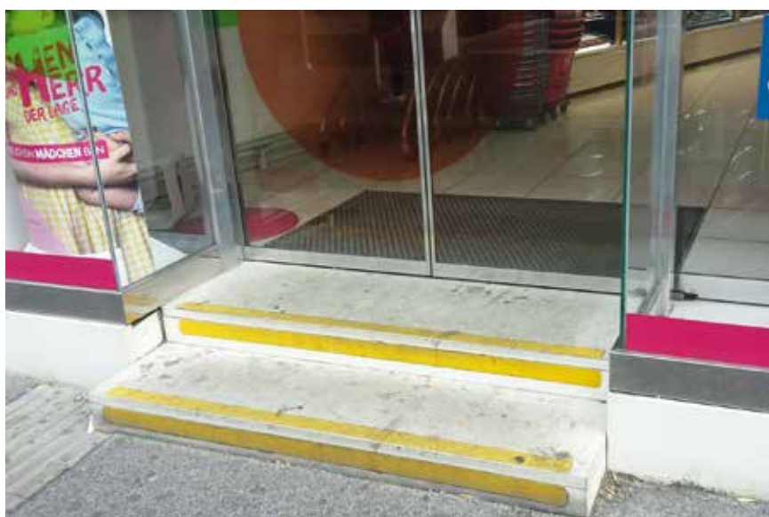
Eingang mit Stufen auf der Favoritenstraße 2018
