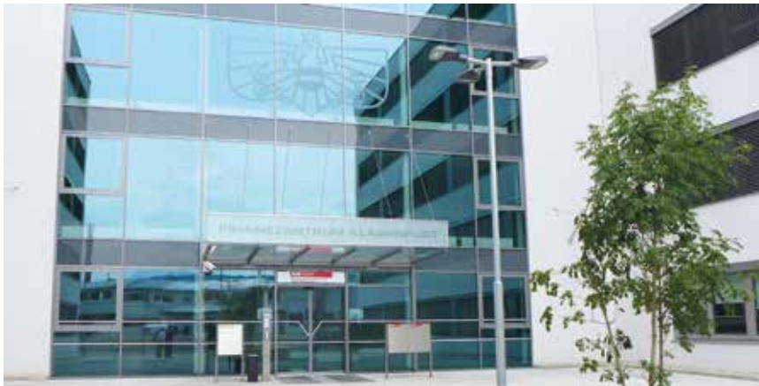
Barrierefreier Haupteingang zum Gebäude
