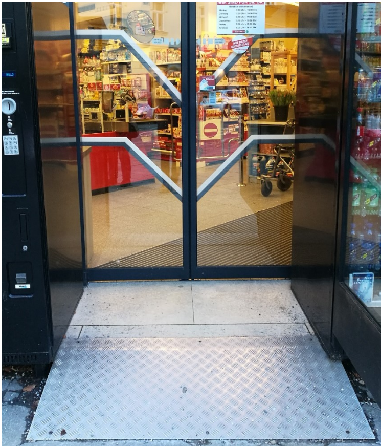
Abbildung 11 Glasmarkierung nach Ö Norm B1600 in Salzburg 2020 © ÖZIV ACCESS
