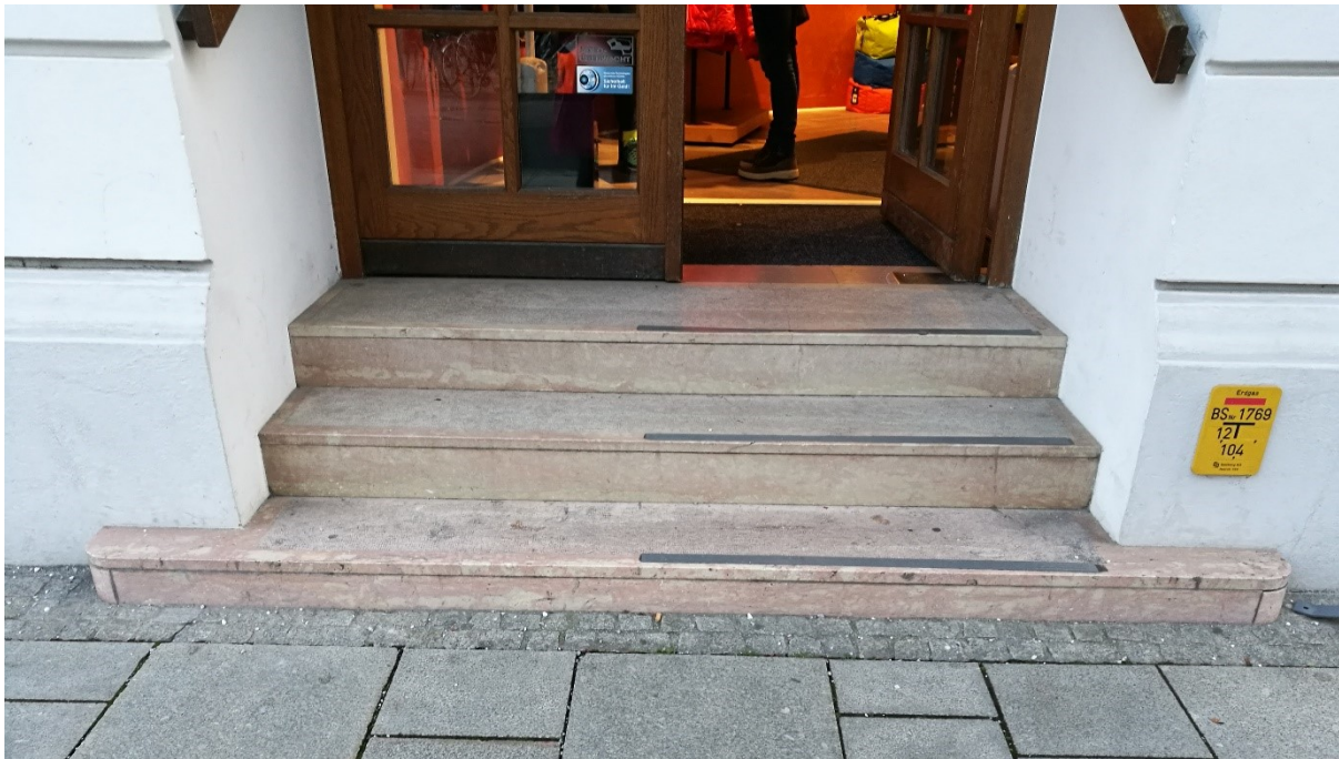
Abbildung 2 Geschäftseingang über 3 Stufen, Salzburg Innenstadt 2020 © ÖZIV ACCESS
