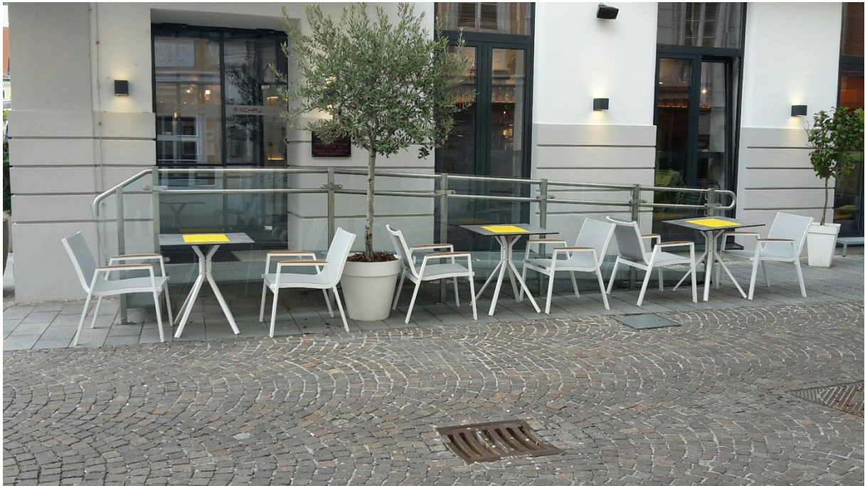
Abbildung 5 Rampenkonstruktion über 2 Stufen, St. Pölten Innenstadt 2019 © ÖZIV ACCESS
