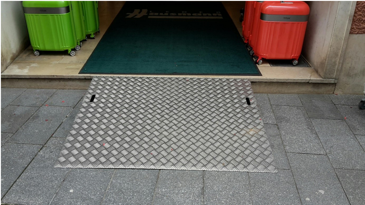
Abbildung 6 Mobile Rampe in St. Pöltnr Innenstadt 2019 © ÖZIV ACCESS
